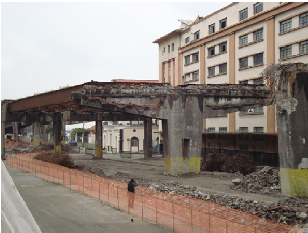
Figura 12 – Trecho do Viaduto da Perimetral junto à Praça XV, já parcialmente demolido pelas obras do Porto Maravilha. Foto do autor. Agosto de 2014.
