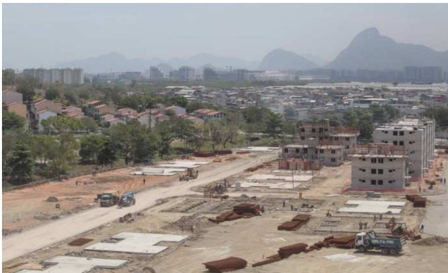
Figura 38 – Canteiro de obras do empreendimento Vila Carioca, no bairro do Anil. Fonte: Agência O Globo/ Pedro Kirilos. Novembro de 2014.
