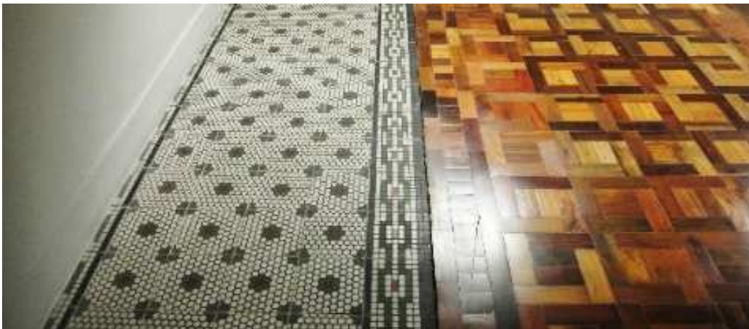
Figura 94- Paginações de piso nos pavimentos onde haviam salas comerciais (ladrilho nas circulações e taco nas salas de escritórios).
