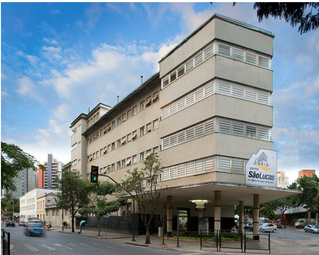
Figura 144 - Hospital São Lucas. Fonte: Santa Casa de Misericórdia de Belo Horizonte.
