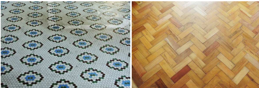
Figura 92 e 93 - Paginações de piso do vestíbulo e das circulações do teatro.
