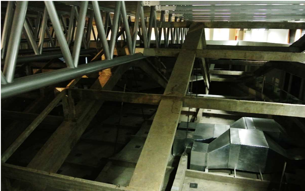
Figura 95 - Estrutura da antiga cobertura em concreto armado.
