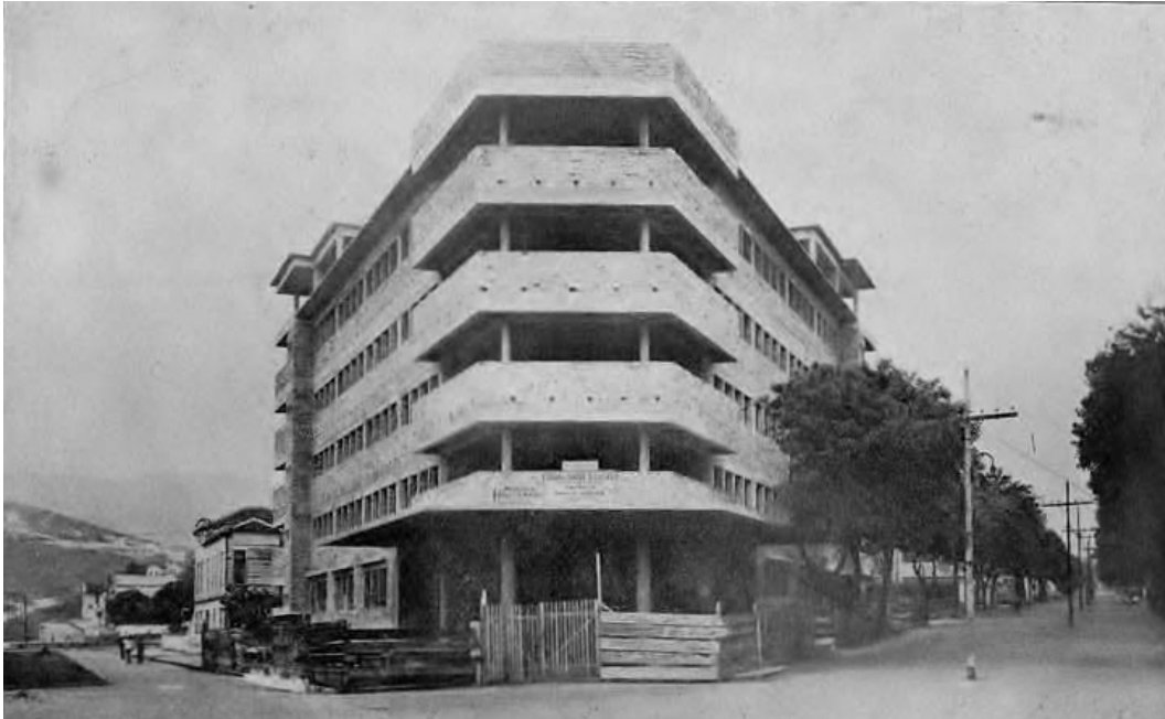
Figura 143 - Hospital São Lucas (ainda em construção, 1937). Fonte: Arquivo Público da Cidade de Belo Horizonte (APCBH);
