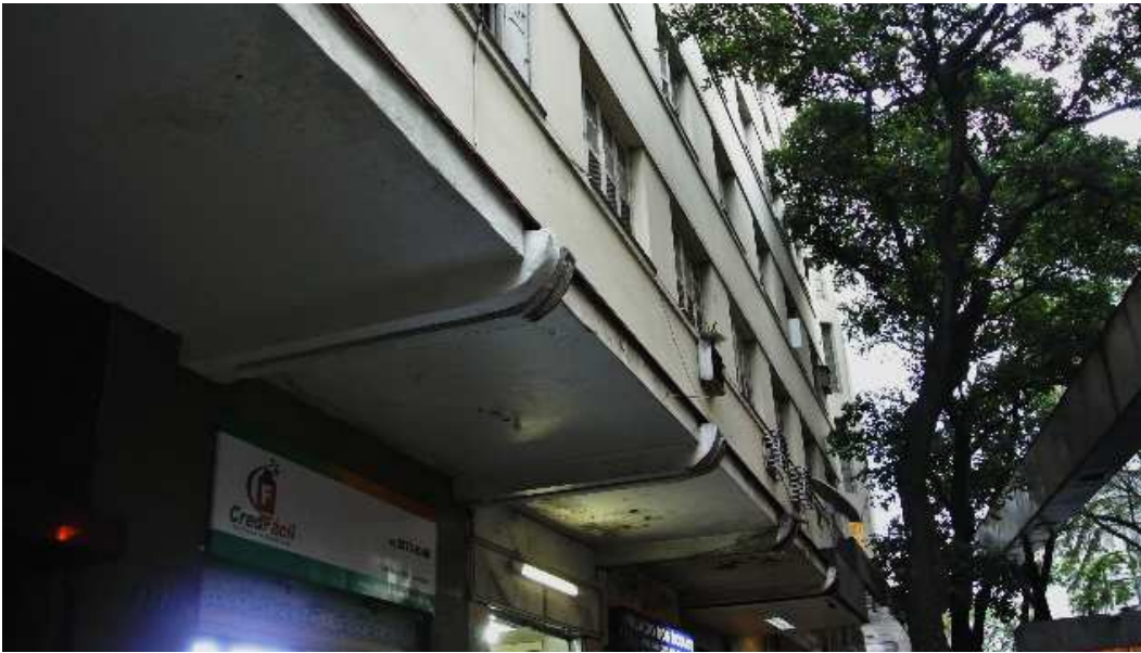
Figura 114 - Detalhe da marquise do Brasil Palace Hotel.
