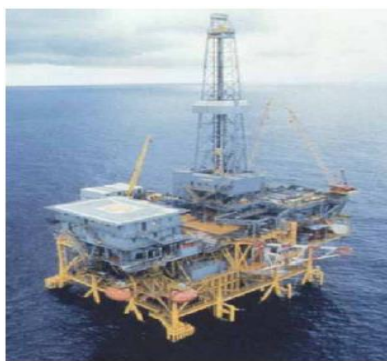
Figura 12: Foto de uma Plataforma Jaqueta [6].
